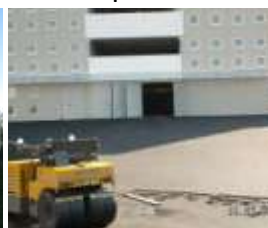
Проведение дорожных работ
